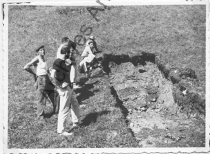
Apparition du fossé large de 6 m.
